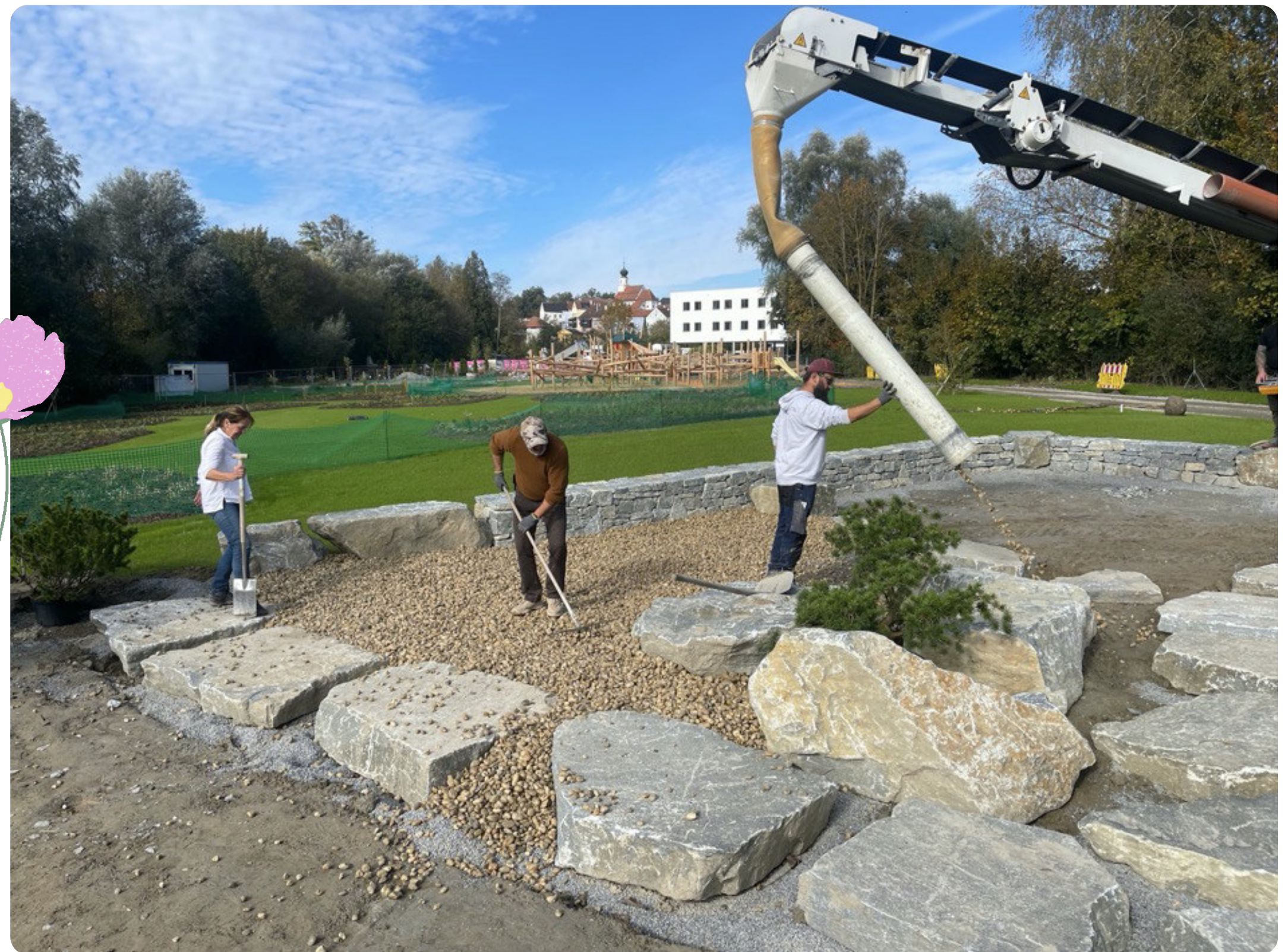
ABBILDUNG 5: ES FOLGTE DIE KIESSCHÜTTUNG
