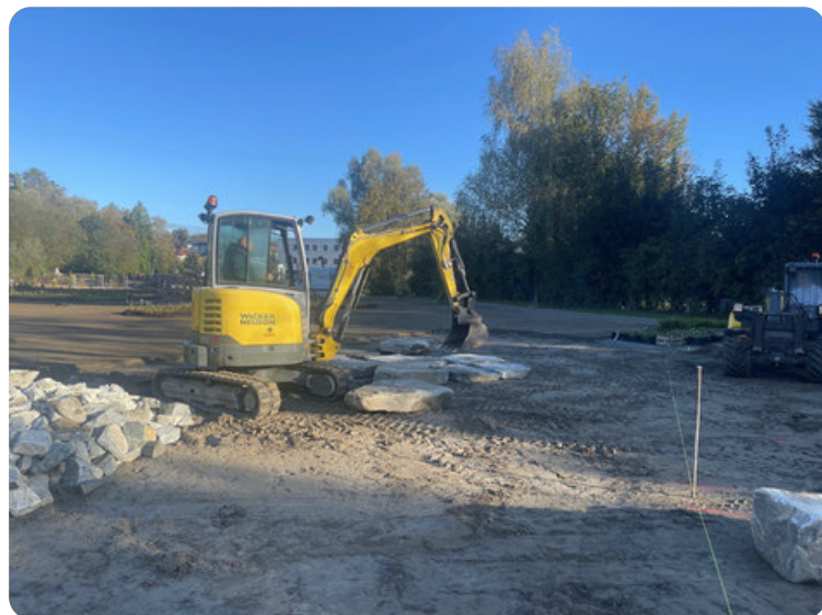
ABBILDUNG 3: DIE ERSTEN TRITTSTEINE WURDEN VERLEGT
